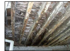
Plafond d'une chambre
